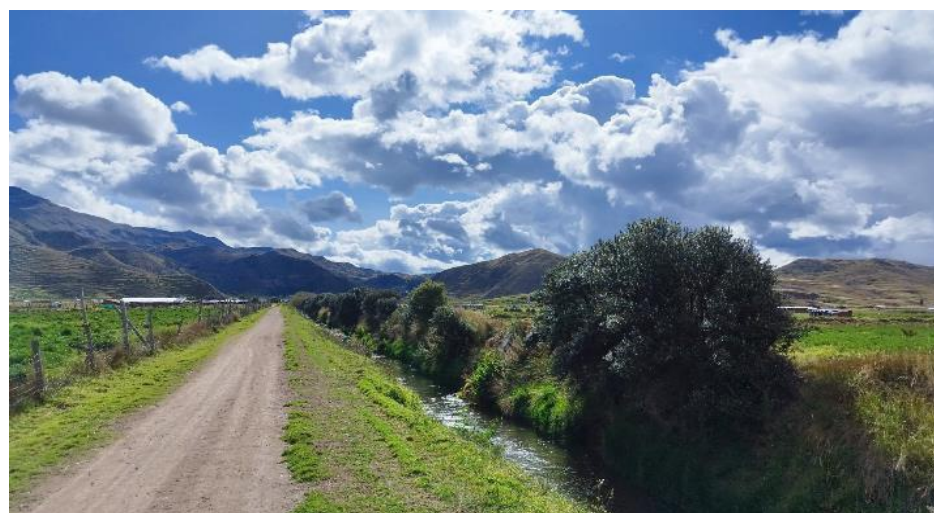
FIGURA N°03: SE APRECIA EL CAUCE DEL RIO TUPAHUIRE, COLMATADO Y DE SECCION HIDRAULICA VARIABLE, SE APRECIA A LA MARGEN IZQUIERDA, CARRETERA DE TROCHA CARROZABLE A LA COMUNIDAD SAN JOSE.
